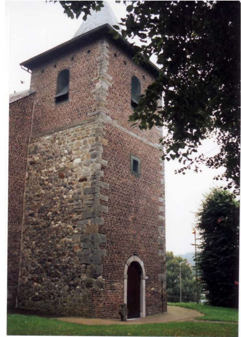
In de toren van de oude kerk te Eyselshoven zijn resten van Romeinse bouwwerken verwerkt. In de fundamenten vond men fragmenten van Romeinse mijlpalen. Een aanwijzing dat hier ergens de Weg gelopen heeft?
