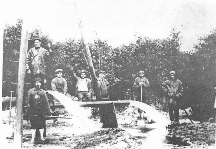
Werklui van de Laura bij de boortoren die het artesisch bekken in Rimbürg heeft aangeboord. Het water komt met grote kracht tevoorschijn.
